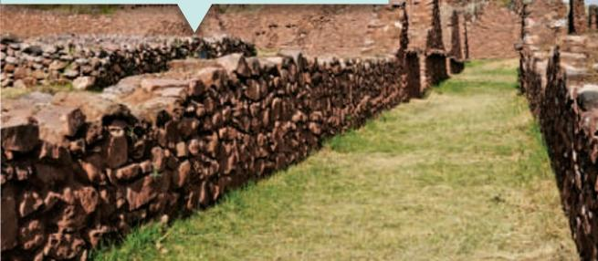
Para dar mayor estabilidad a sus muros, los huari utilizaban bases anchas y argamasa.
